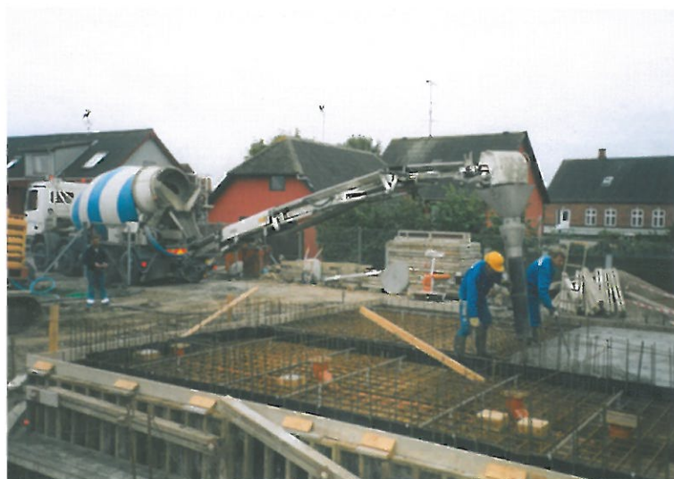
Der støbes dæk over rentvandsbassinet under den seneste udvidelse af vandværket for ti år siden.
