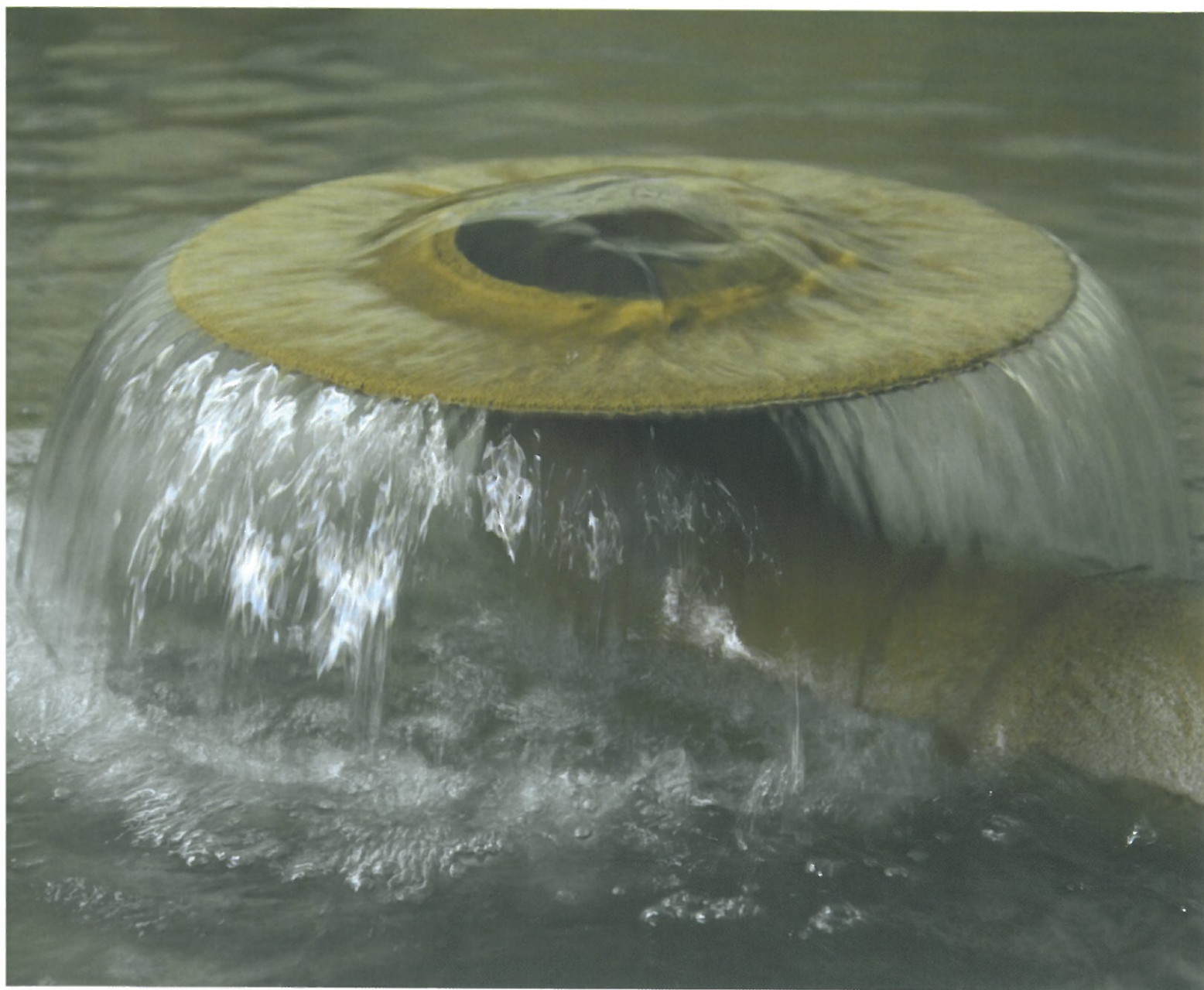
Efter iltning pumpes råvandet ind filtreringsanlægget, hvor jern, mangan og eventuelle småpartikler sies fra.
